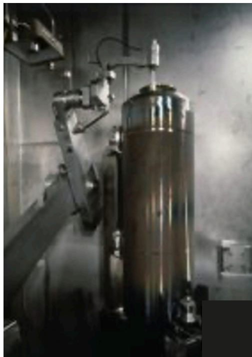
ABBILDUNG 39 | Glaskokille beim Schweißen des Deckelflanschverschlusses in VEK 31 .
